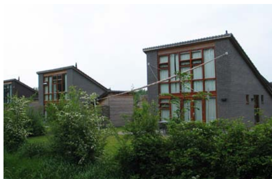
EEN INGETOGEN KLEURGEBRUIK VAN DE BEBOUWING EN LANDSCHAPPELIJKE BEPLANTING
