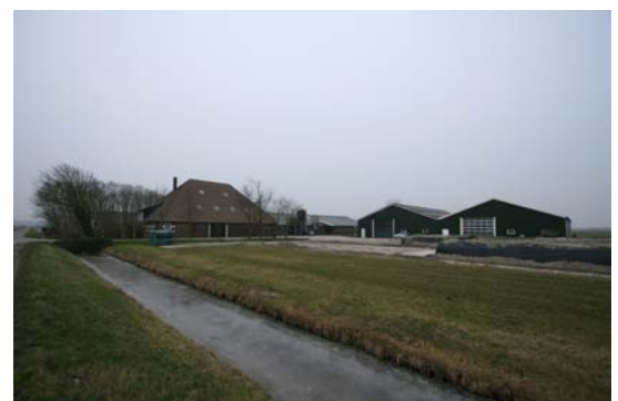
WOONHUIS MET BEPLANTING VOOR DE SCHUREN
