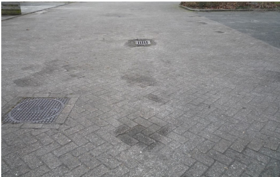
Elementenverharding: Kwaliteitsklasse matig
