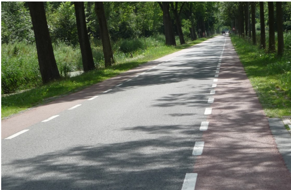
Asfaltverharding: kwaliteitsklasse goed/voldoende
