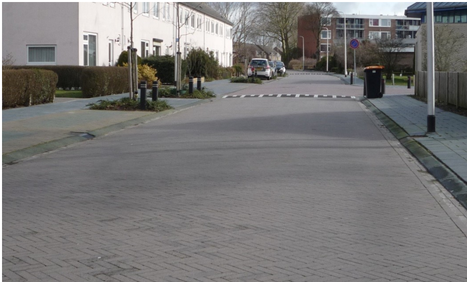
Elementenverharding: Kwaliteitsklasse goed/voldoende
