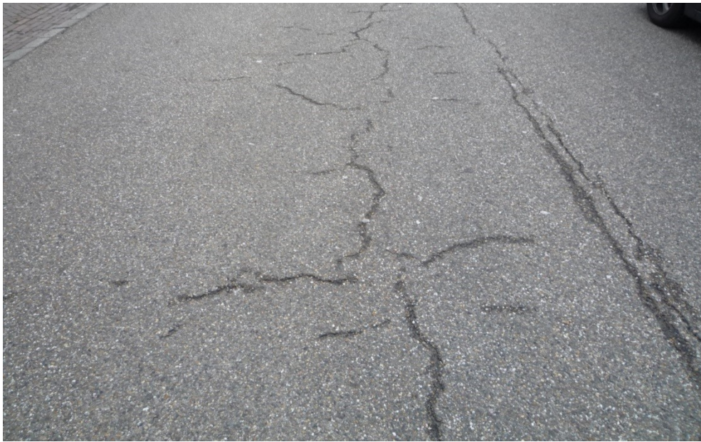
Asfaltverhardingen: kwaliteitsklasse matig
